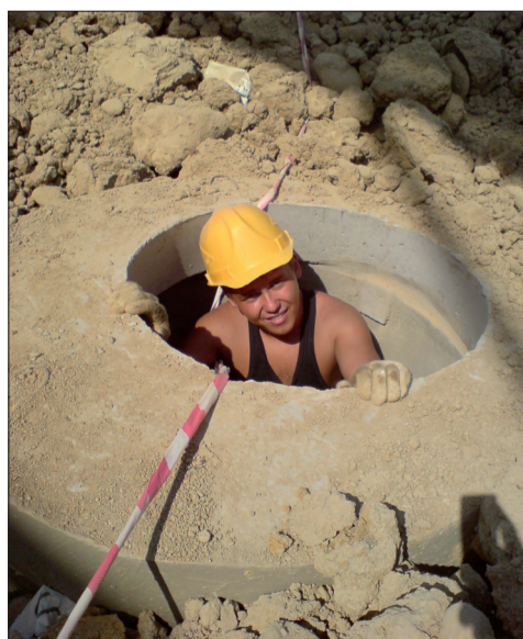
Студенты МГТУ на строительстве олимпийских объектов в г. Сочи
