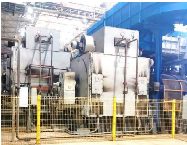
Рисунок 3.19. Фотографии двигателей электроприводов клетки и моталки
