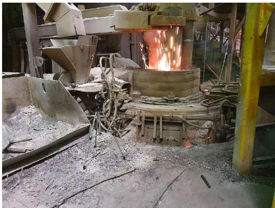
Рис.2.2 – Общий вид УПК№2 емкостью 120 тонн функционирующей в ПАО «Северсталь»
