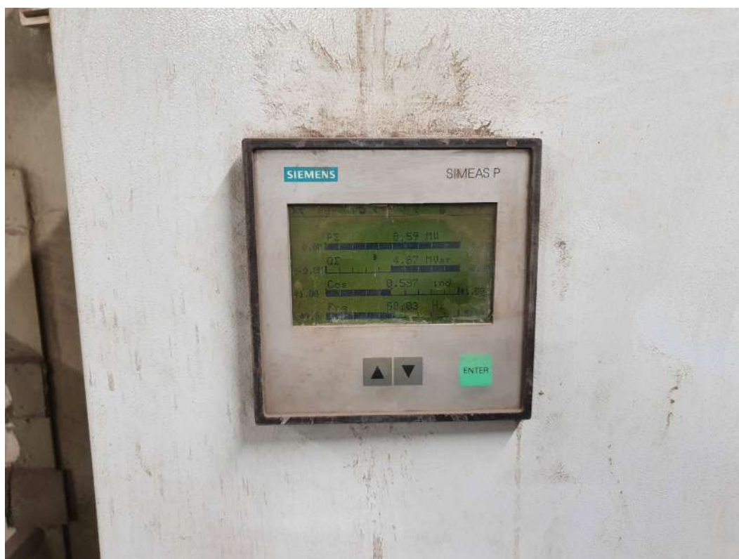
Рис. 5.16 – Анализатор мощности SIMEAS P установленный в ШУ УКП№2 120т. ПАО «Северсталь»
