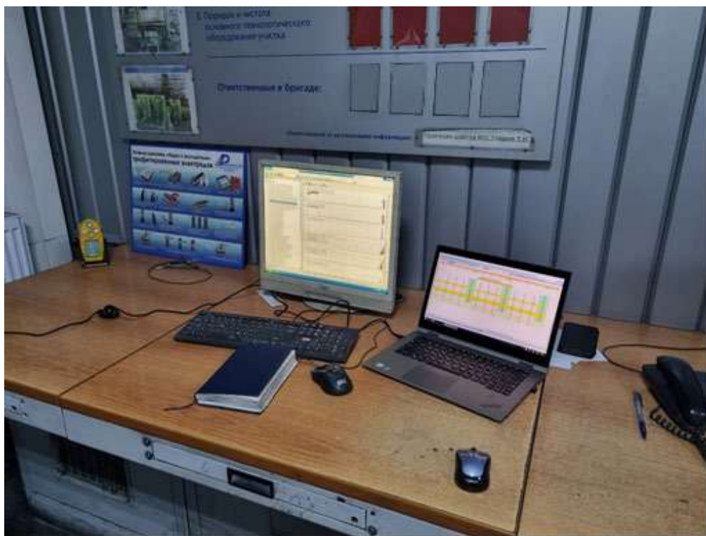
Рис. 5.1 - Рабочее место при наладке электрических режимов и усовершенствованных алгоритмов автоматического управления электрическими режимами УПК№1 180т. ПАО «ММК»
