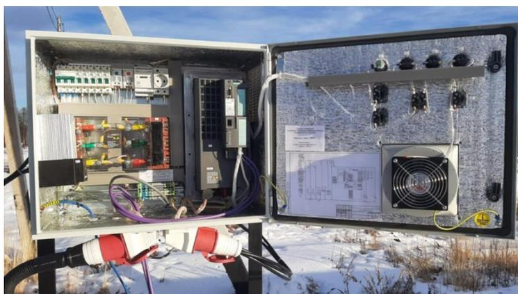
Рисунок. Д 2 – Станция управления технологическим блоком в теплоизоляционном боксе (второй уровень управления)
