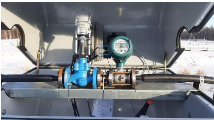
Рисунок Д 1 – Расходомер и регулирующий клапан с электроприводом в теплоизоляционном боксе (первый - полевой уровень управления «Умного полигона СПВ»)
