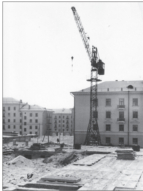
Строительство учебного корпуса на правом берегу, 1954 г.
