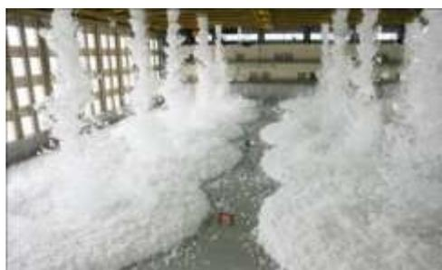
Рисунок 4 - Спринклерная установка пожаротушения
