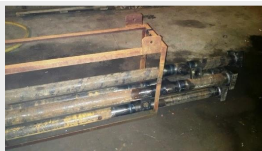
Перед началом работ
