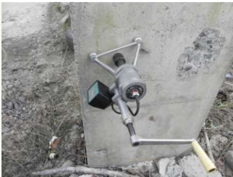
Предварительное обследование зданий и сооружений
