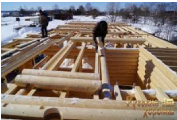
Рисунок Укладка бревен
