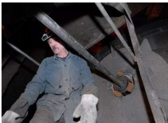
Рис. 3 Ремонт сталевыпускного отверстия (расклинивание периклазовым кирпичем)
