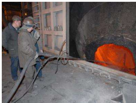
Рис. 4 Ремонт сталевыпускного отверстия (заполнение зазоров)
