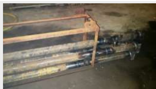
Перед началом работ
