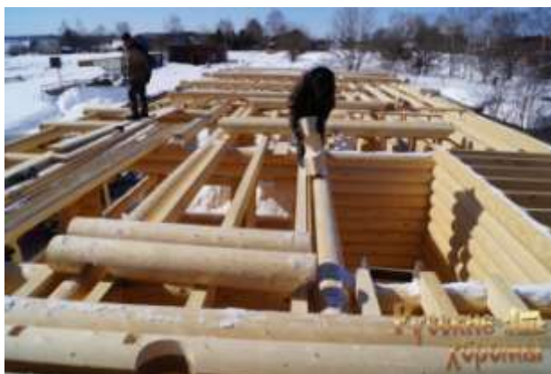
Рисунок Укладка бревен
