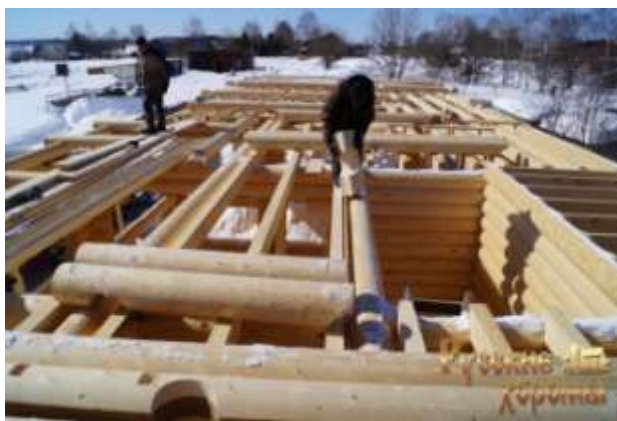
Рисунок Укладка бревен
