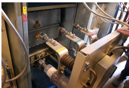
Рис №37 – вакуумный выключатель
