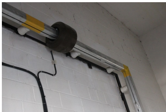
Рис 36 – Трансформатор тока
