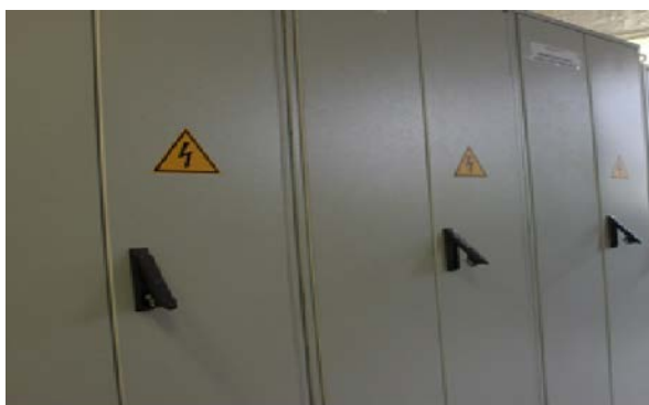
Рис 5 – Щит собственных нужд
