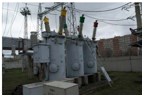
Рис 16 Масляный выключатель
