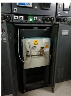
Рис 42 – Выключатель масляный
