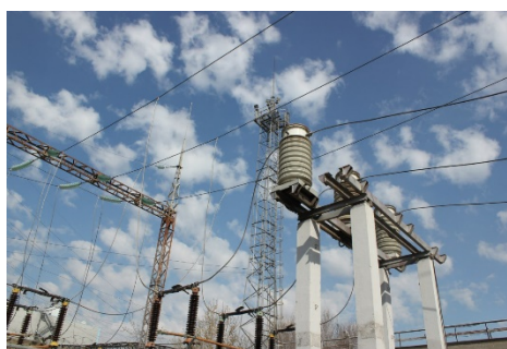
Рис 27 – Элегазовые выключатели
