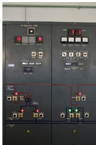
Рис 3 - Мнемосхема
