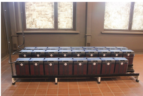
Рис 32 – Аккумуляторные батареи
