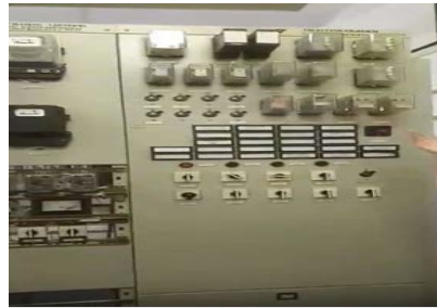
Рис 22 – Релейная защита
