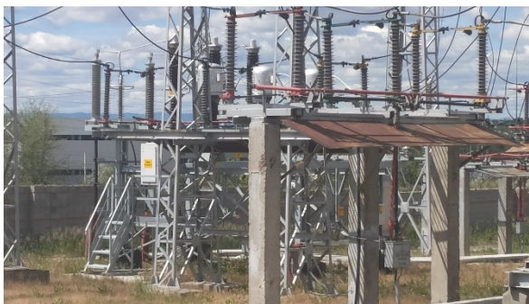
Рис 40 – Трансформаторы напряжения
