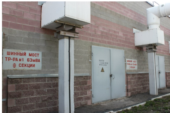
Рис 34 – Шинный мост
