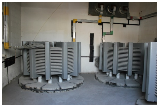
Рис 35 – Токоограничивающий реактор
