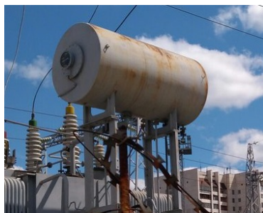
Рис 17 - Расширительный масляный бак
