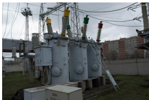
Рис 16 Масляный выключатель
