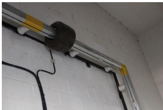
Рис 36 – Трансформатор тока
