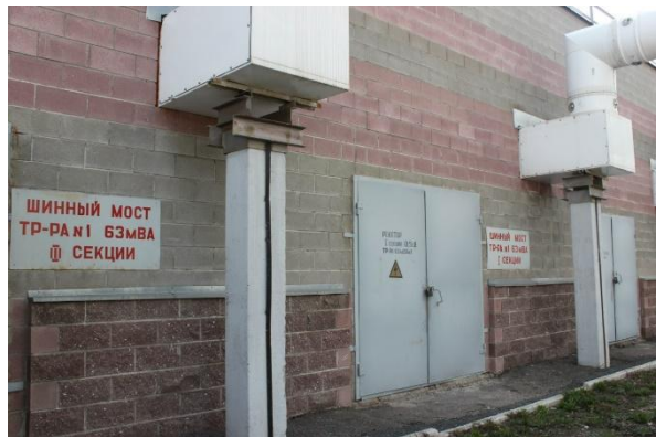
Рис 34 – Шинный мост
