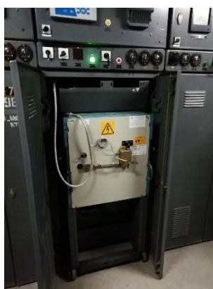
Рис 42 – Выключатель масляный
