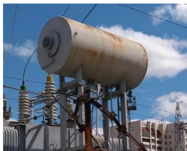
Рис 17 - Расширительный масляный бак
