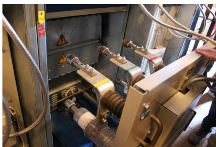
Рис №37 – вакуумный выключатель
