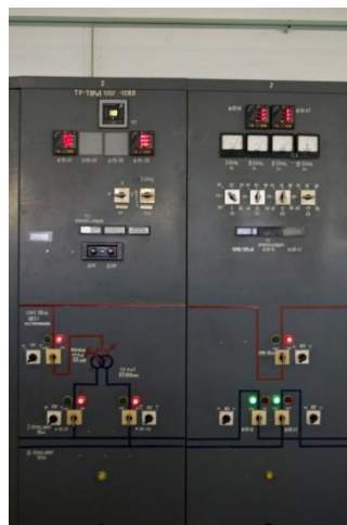
Рис 3 - Мнемосхема
