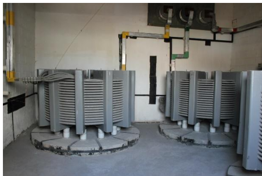
Рис 35 – Токоограничивающий реактор
