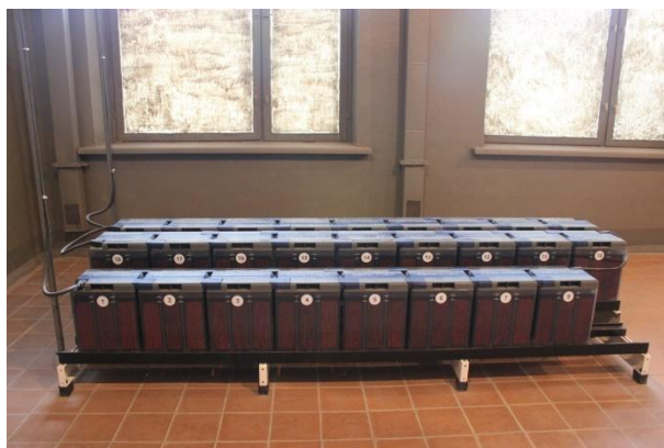
Рис 32 – Аккумуляторные батареи
