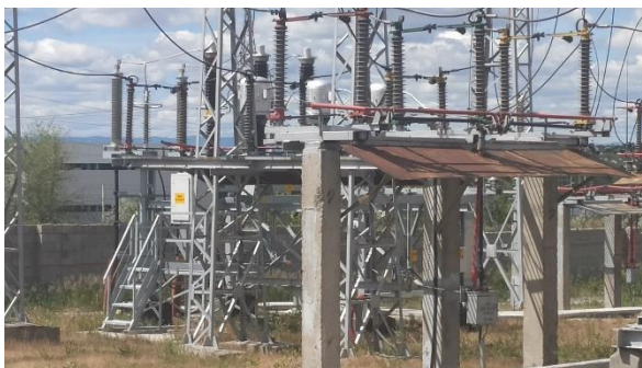
Рис 40 – Трансформаторы напряжения
