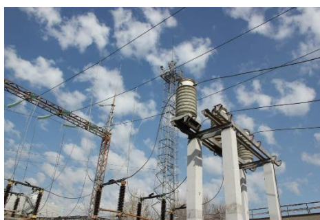
Рис 27 – Элегазовые выключатели
