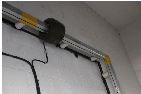
Рис 36 – Трансформатор тока
