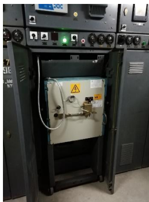
Рис 42 – Выключатель масляный
