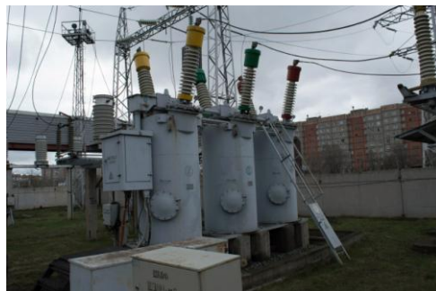
Рис 16 Масляный выключатель
