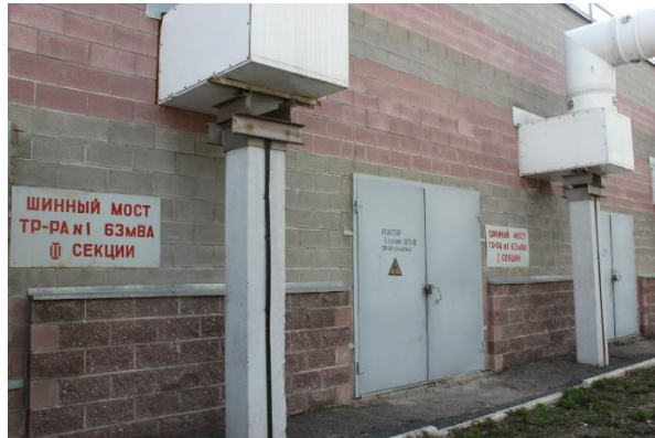
Рис 34 – Шинный мост
