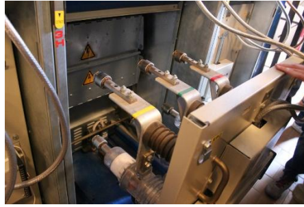
Рис №37 – вакуумный выключатель
