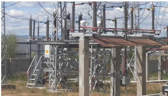
Рис 40 – Трансформаторы напряжения
