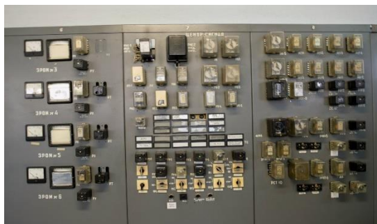
Рис 4- Панель сигнализации
