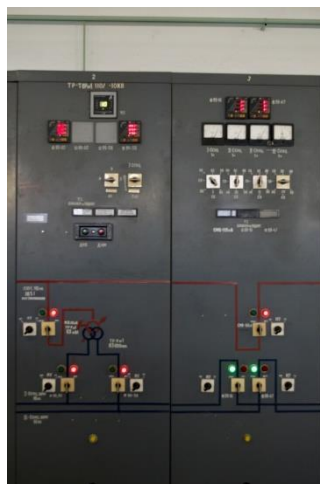
Рис 3 - Мнемосхема
