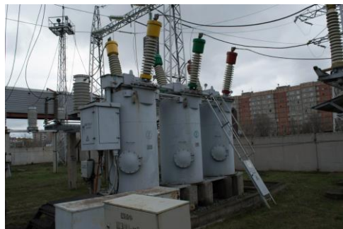
Рис 16 Масляный выключатель
