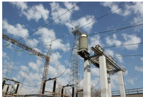
Рис 27 – Элегазовые выключатели
