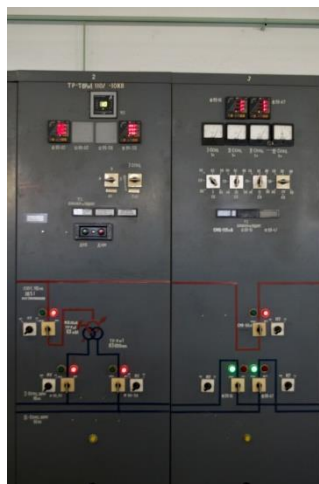
Рис 3 - Мнемосхема
