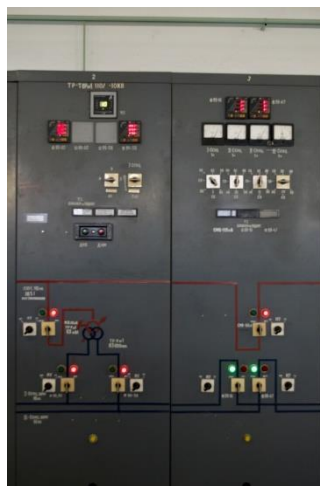
Рис 3 - Мнемосхема
