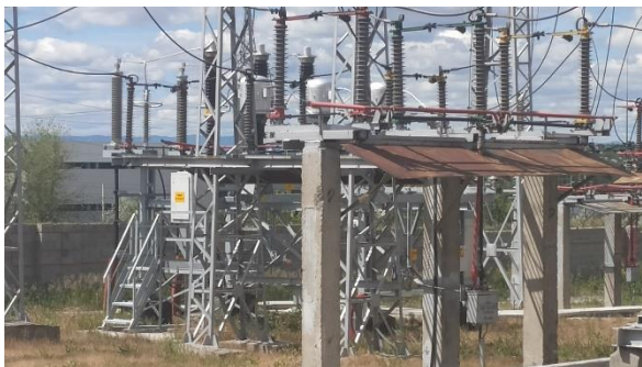
Рис 40 – Трансформаторы напряжения
