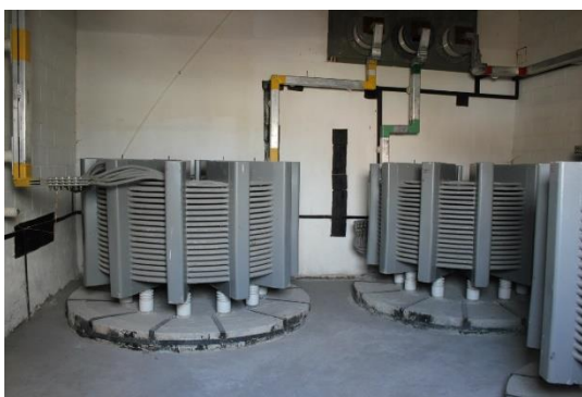
Рис 35 – Токоограничивающий реактор
