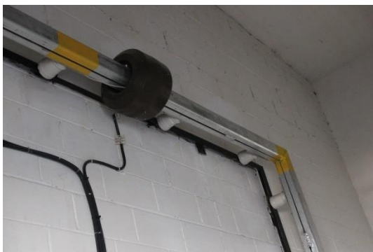
Рис 36 – Трансформатор тока
