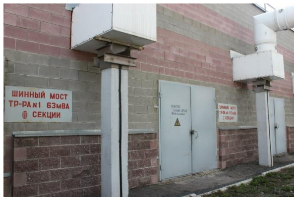
Рис 34 – Шинный мост
