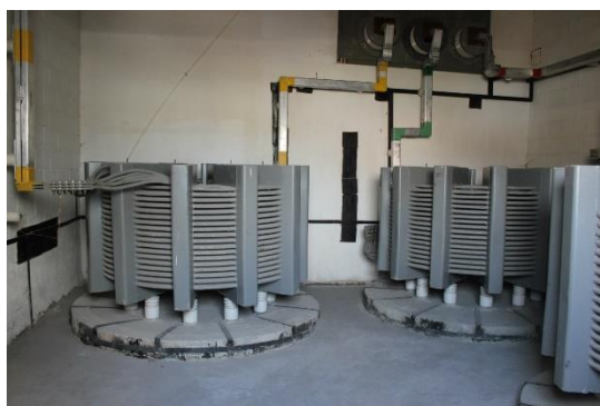
Рис 35 – Токоограничивающий реактор
