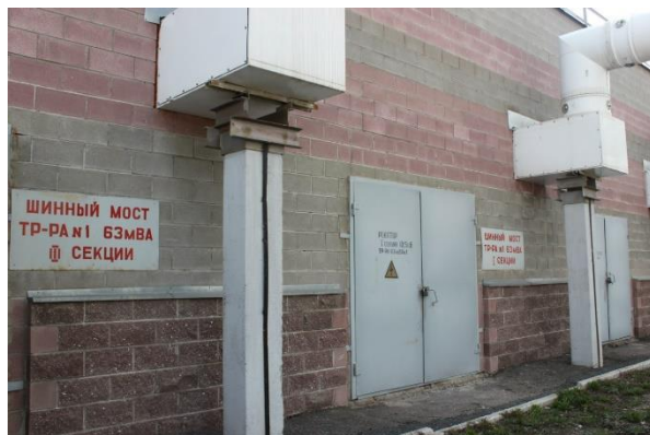
Рис 34 – Шинный мост
