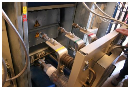
Рис №37 – вакуумный выключатель
