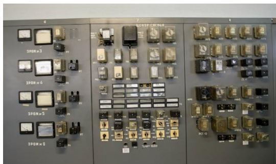
Рис 4- Панель сигнализации
