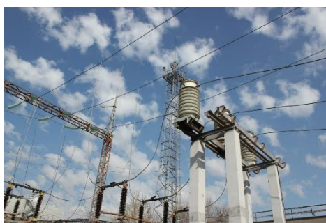
Рис 27 – Элегазовые выключатели
