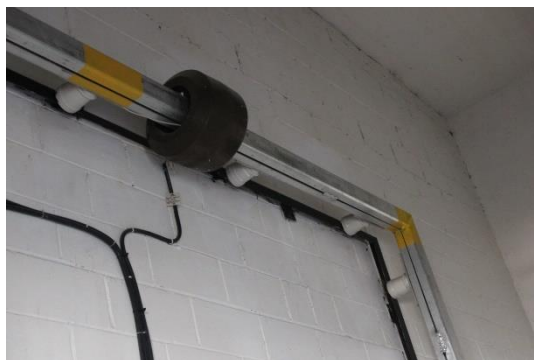
Рис 36 – Трансформатор тока
