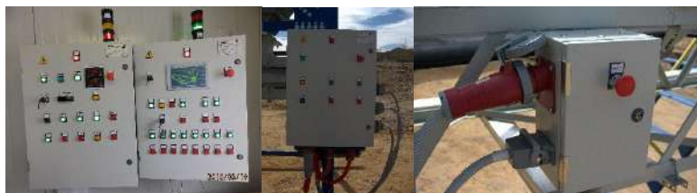
Рис. 2. Фотографии АСУ ДСК ЗАО «Урал-Омега», поставленной для ООО «ОКС»
