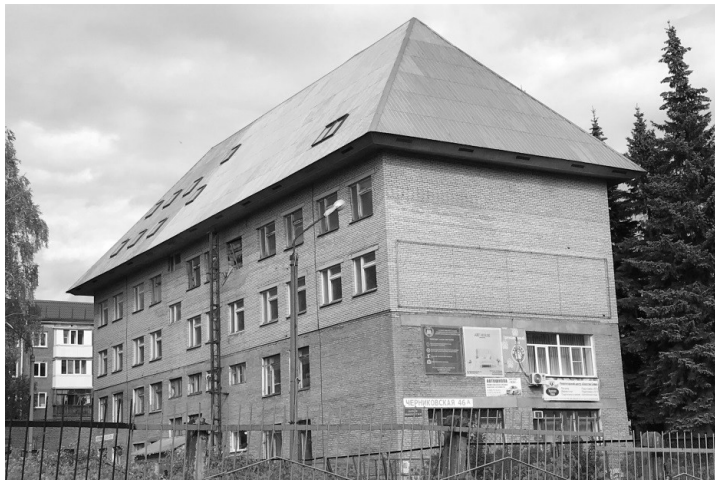
Рисунок 1 - Общий вид здания (западное крыло) колледжа с мансардой, утепленной при помощи монолитного крупнопористого керамзитобетона
