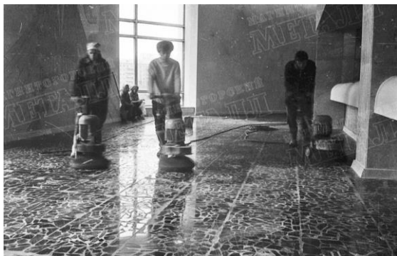
Рис. 8. Магнитогорский цирк. Укладка и полировка пола
