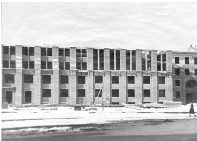
Строительство учебного корпуса МГМИ (1959 г.)
