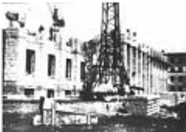
Строительство нового здания МГМИ (1957 г.)
